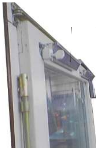
Nawiewnik z regulacją ręczną
